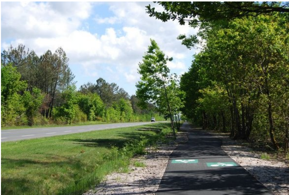
La piste cyclable facilite les déplacements non motorisés et permet un traitement intéressant des bords de route, Marcheprime crédits : Agence Folléa-Gautier
