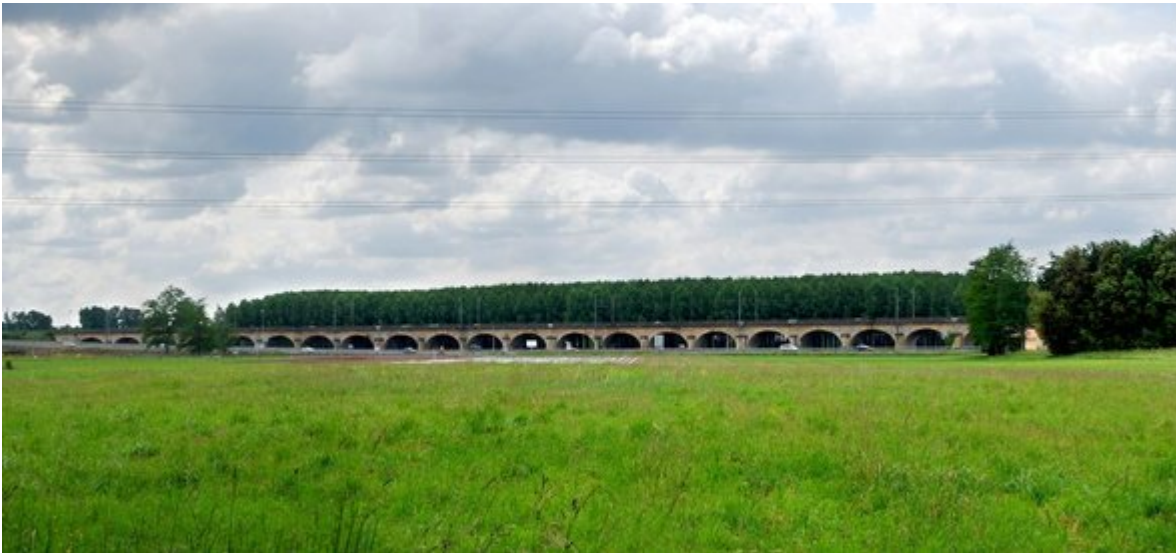
Ce viaduc datant de 1855 permet le franchissement des zones inondables de la vallée - Saint-Macaire crédits : Agence Folléa-Gautier
