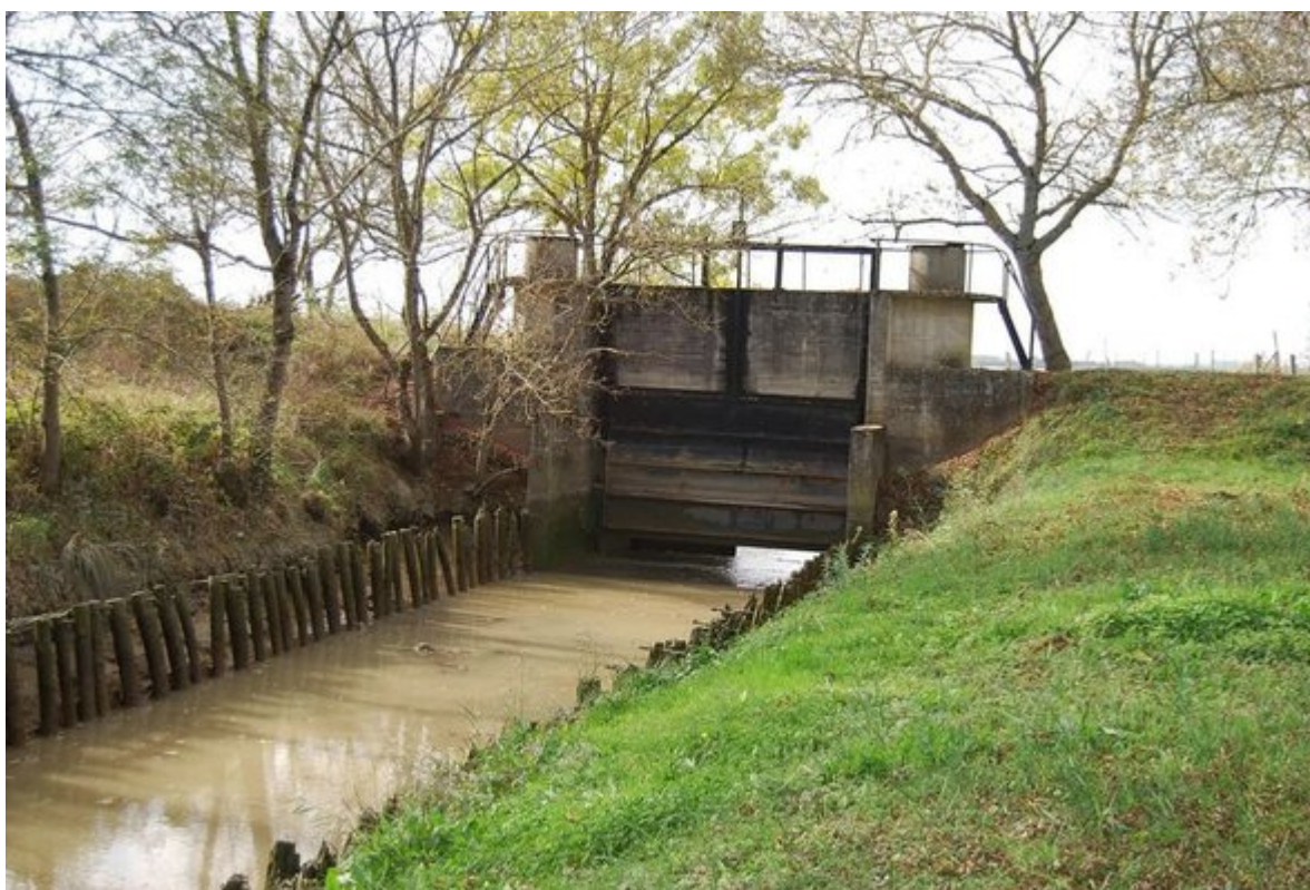
Portes à flots assurant la communication entre le palus et l'estuaire et permettant la maîtrise des niveaux d'eau dans le marais (palus du Nord Médoc) crédits : Agence Folléa-Gautier
